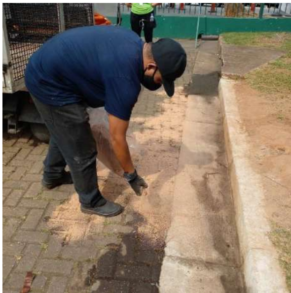
Figura 49: Aplicação de material absorvente para remoção do óleo
