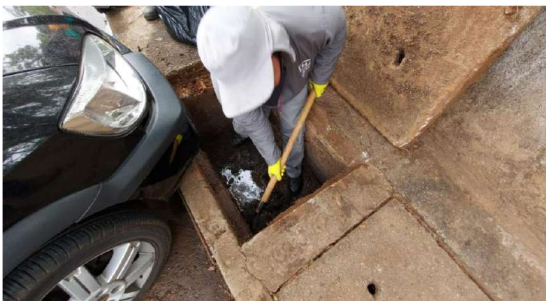
Figura 50: Limpeza das caixas de drenagem, totalmente contaminadas.
