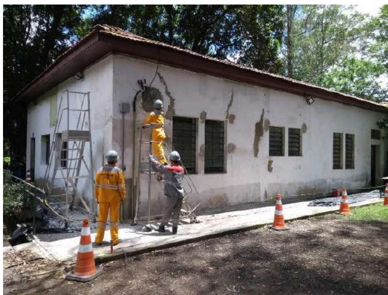
Figura 74: Reforma da CECCO
