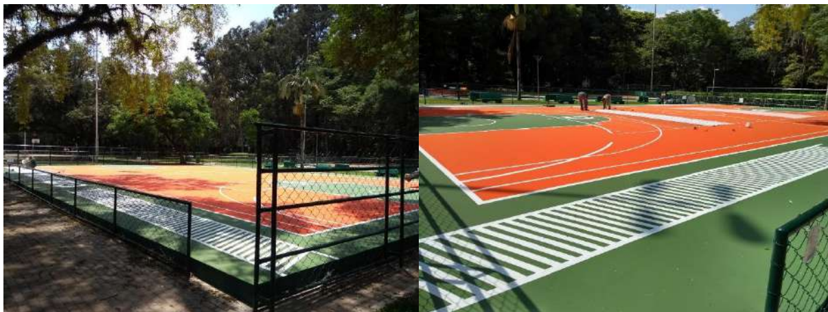
Figura 75: Reforma da quadra
