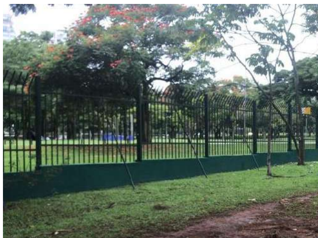
Figura 79: Reforma e pintura do gradil
