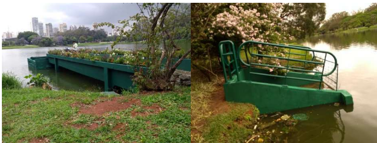
Figura 80: Pintura dos vertedouros
